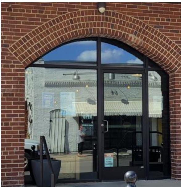
Metal framed entry door
